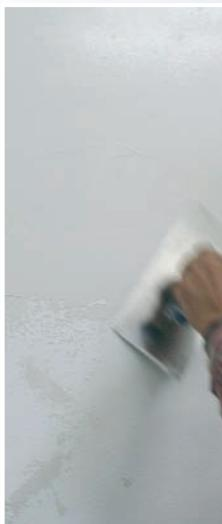
Der Profi-Kalkspachtel gleicht ungleichmäßig saugende Untergründe, z. B. Gipskartonplatten vor dem Anstrich mit Profi-Kalkprodukten aus. Er eignet sich sowohl zur Ausbesserung kleiner Fehlstellen als auch zur Egalisierung des Untergrundes. Die pulverförmige Spachtelmasse zum Selbstanröhren ist hoch diffusionsoffen und kann mit einem Spachtel oder Glättkelle bis max. 3 mm Schichtdicke aufgetragen werden.
