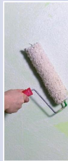
Die Profi-Silikatgrundierung ist der ideale Voranstrich für die Anwendung der Profi-Kalkfarbe im Außenbereich. Die Fläche wird dabei optimal verfestigt und verkieselt. Sie wird mit der Bürste oder Rolle aufgetragen und ist nach 24 Stunden überarbeitbar. Ihre weiße Pigmentierung sorgt für eine bessere Deckkraft des Folgeanstriches, besonders bei dunkleren Untergründen. Sie verkieselst vollständig mit allen mineralischen Untergründen.
